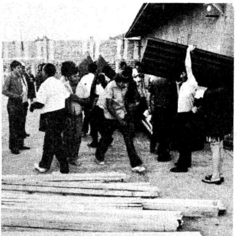
Villa Sapito: apagado el incendio ya surgen nuevas casillas.
