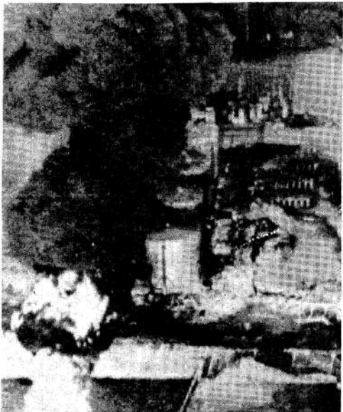
PETAL, MISSISSIPPI, EE.UU. (R-L).— Los 9.000 habitantes de esta ciudad abandonaron apresuradamente sus casas debido a que el incendio de un depósito subterráneo de gas amenazaba con extenderse a otros tanques de almacenaje. No hubo que lamentar víctimas. Los daños fueron cuantiosos. (Radiofoto AP)
