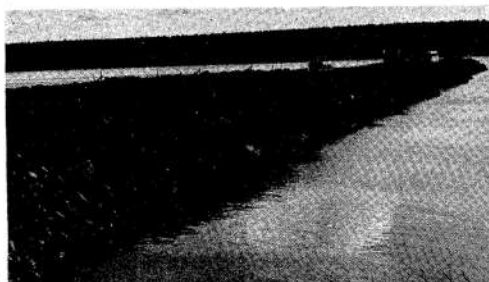
La atagüa es un terraplén que tendrá 22 metros de alto por 15
