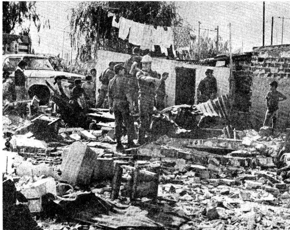
Sobre terrenos que valen millones las casas comenzaron a ser demolidas para dar espacio a la autopista. El ejército actúa
