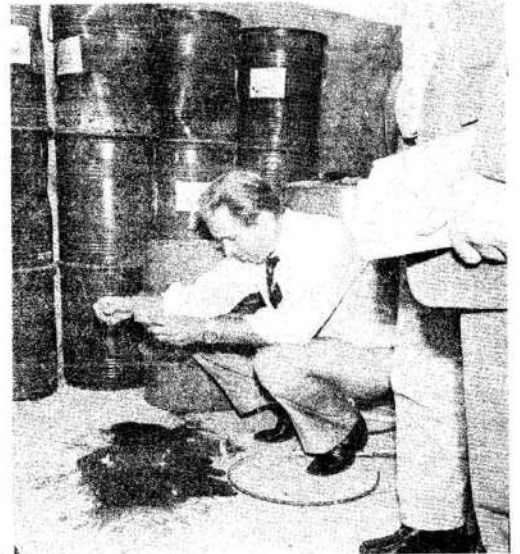
Expertos inspeccionan depósitos de material inflamable.
