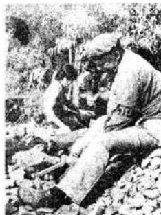
Preparando escombros para cimientos.
