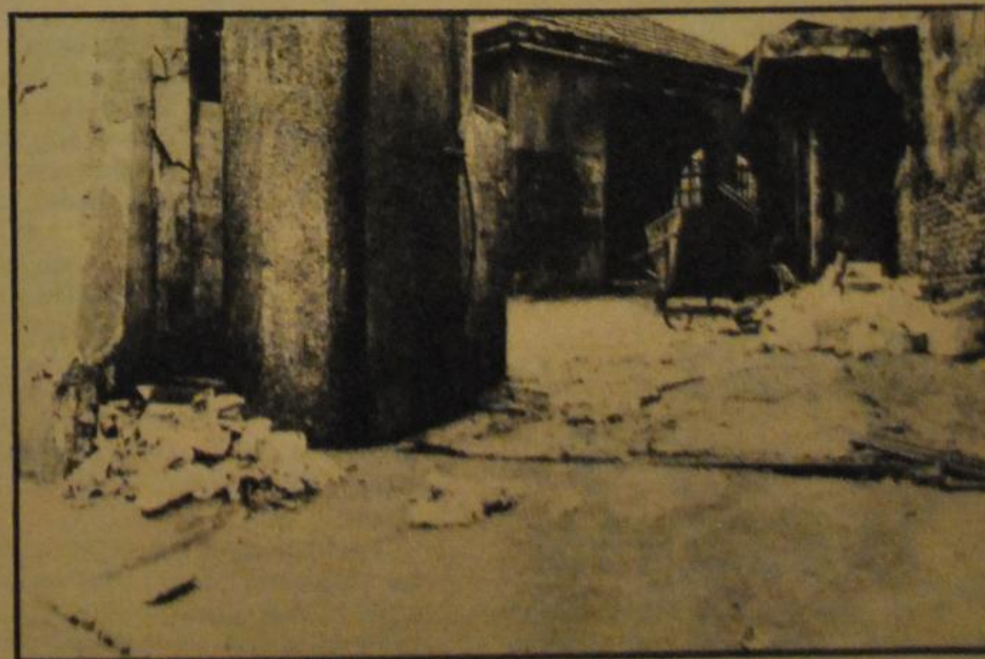
Esta es la puerta de entrada a la cocina del Hospital Rawson. Todo tipo de basura se amontona en los alrededores de la misma. En este aspecto la situación resulta particularmente reveladora. Por otra parte los alimentos que salen de aquí nada tienen que ver con la dieta necesaria.
