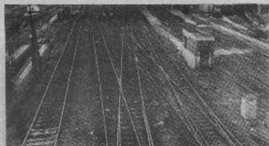
Puro Ferroviario: determinación de la base.
