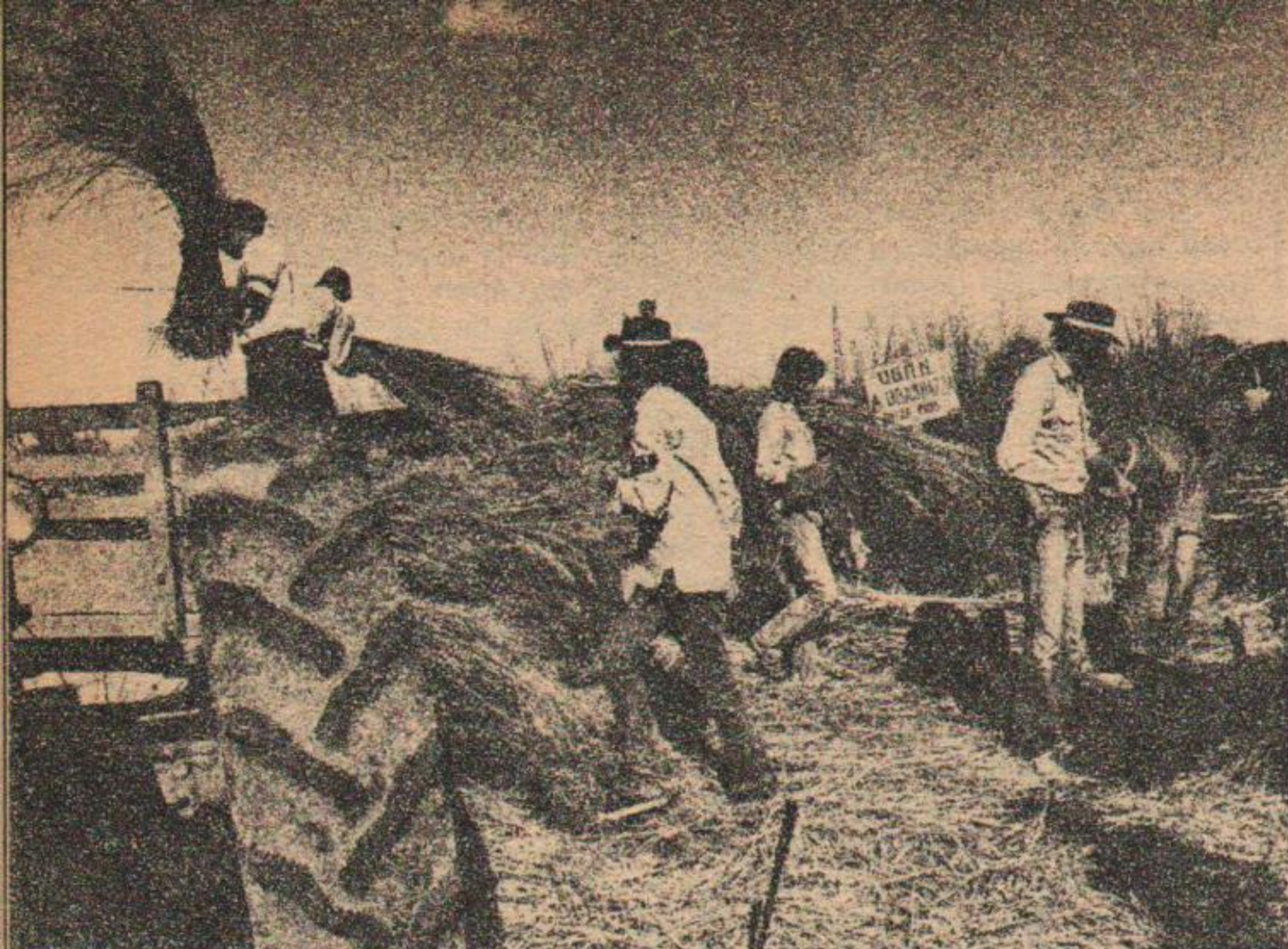
En Villa Ana la U. B. R. N. "Brandazza" hace cortes de paja para los ranchos de los trabajadores santafecinos. Cuarenta grados a la sombra, mosquitos y cansancio. Así durante ocho horas diarias. Así se reconstruye junto al pueblo.
