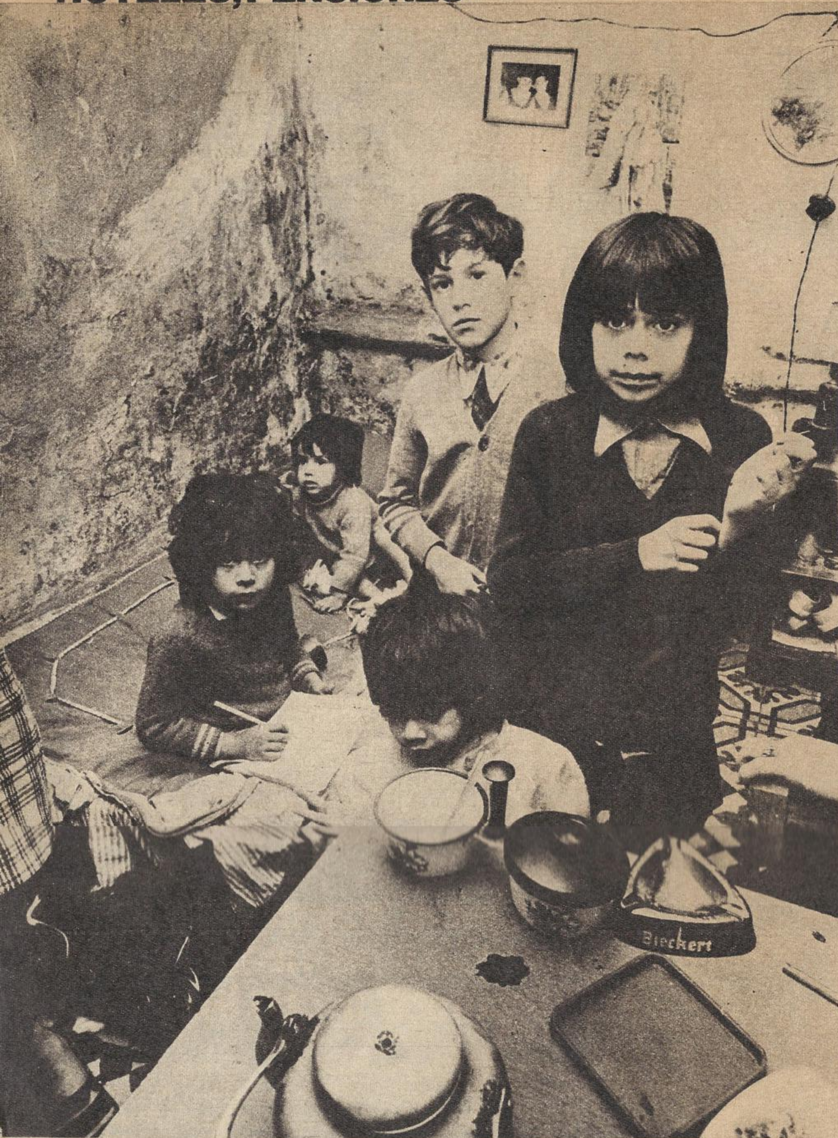
Paredes carcomidas por la humedad. Caras que preguntan por qué. Detrás, un negocio a costa —como siempre— de los pobres.
