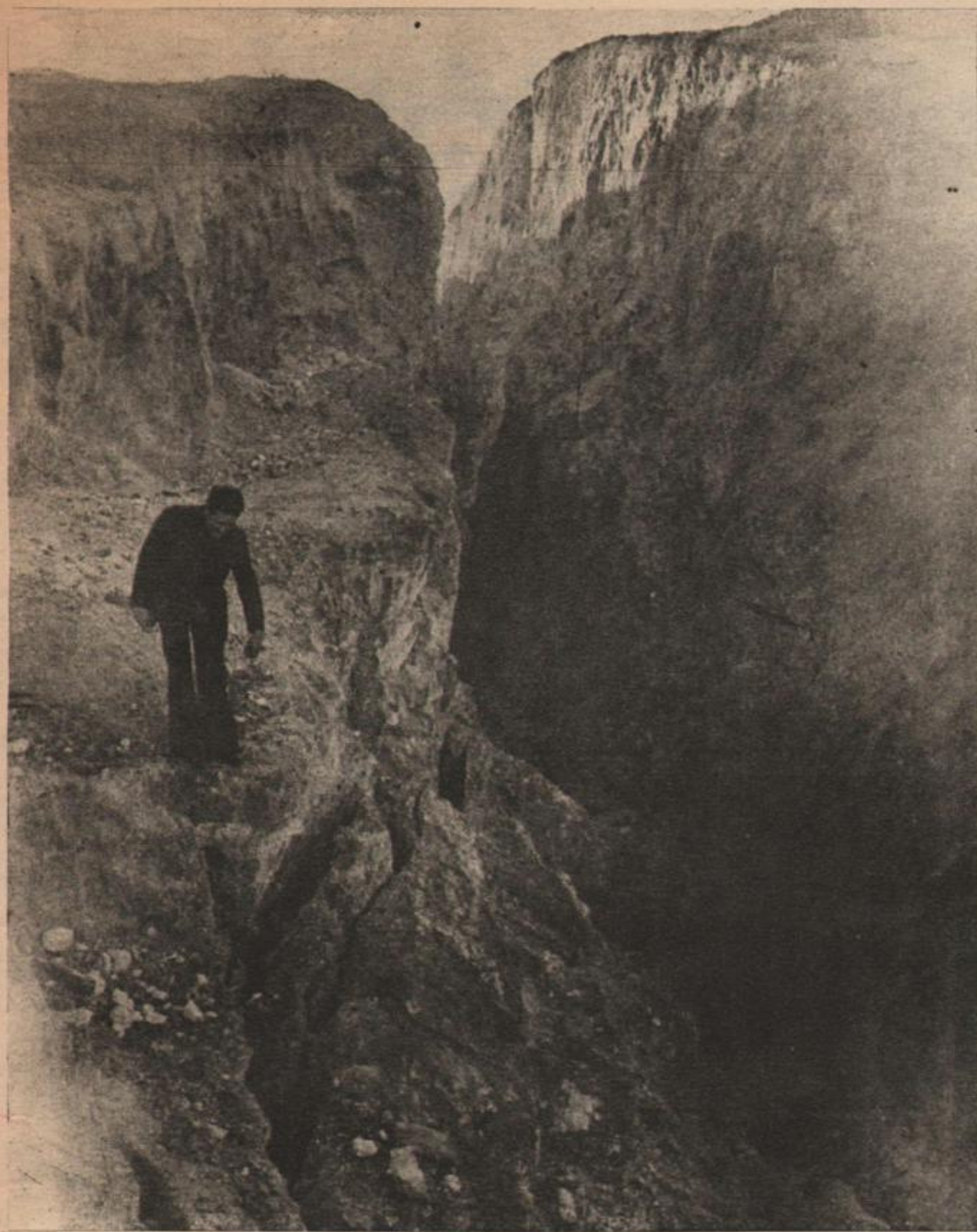
Un compañero de la mina Delta señala una grieta; un futuro derrumbe. Los mineros los esquivan porque tienen "un sexto sentido".
